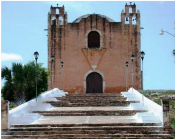
FACHADA DEL INMUEBLE
