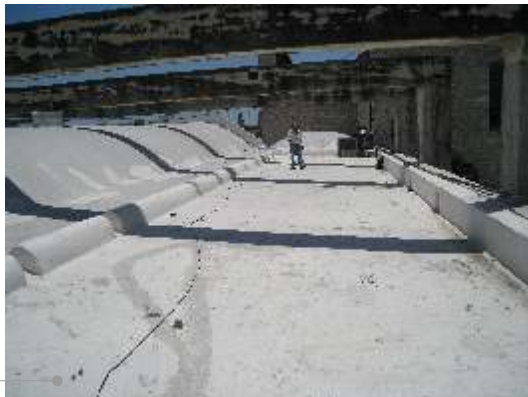
Sistema de impermeabilización acrílico en la azotea
