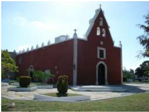
FACHADA DEL INMUEBLE
