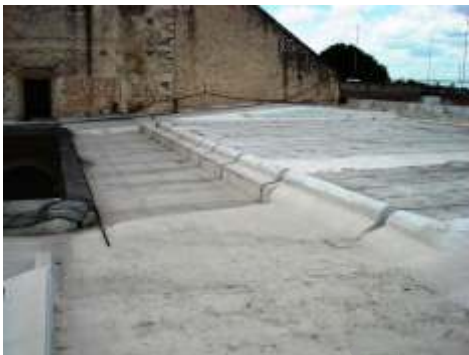
Sistema de impermeabilización acrílico en la azotea
