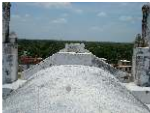
Sistema de impermeabilización acrílico en la azotea
