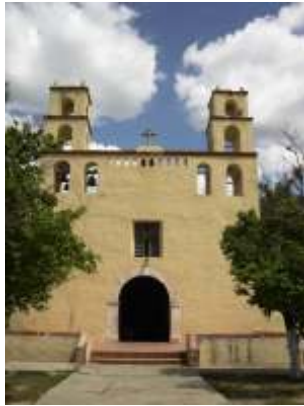
FACHADA DEL INMUEBLE
