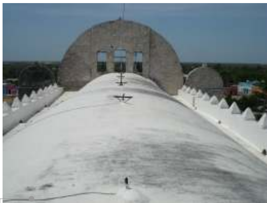
Sistema de impermeabilización acrílico en la azotea
