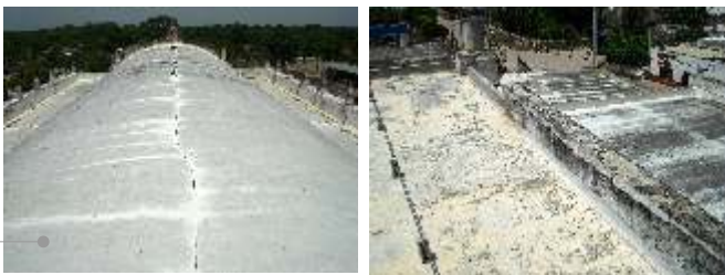
Mantenimiento de impermeabilización acrílico en la azotea
