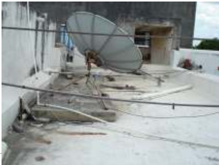
Sistema de impermeabilización acrílico en la azotea
