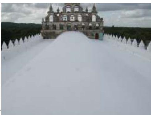
Sistema de impermeabilización acrílico en la azotea
