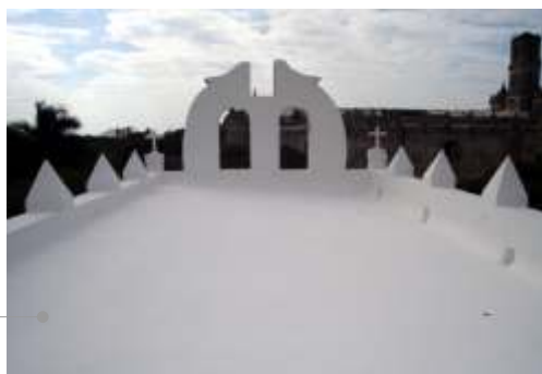
Sistema de impermeabilización acrílico
