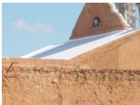
Sistema de impermeabilización acrílico en la azotea
