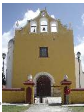
FACHADA DEL INMUEBLE
