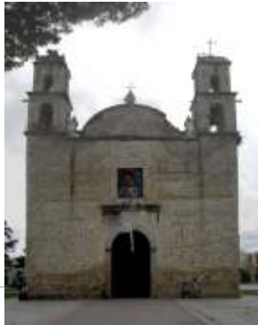
FACHADA DEL INMUEBLE
