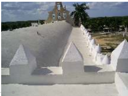
Sistema de impermeabilización acrílico en la azotea
