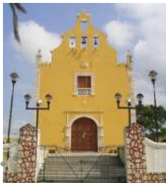
FACHADA DEL INMUEBLE
