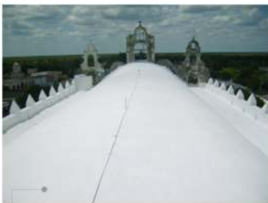
Sistema de impermeabilización acrílico en la azotea
