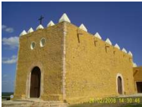
FACHADA DEL INMUEBLE
