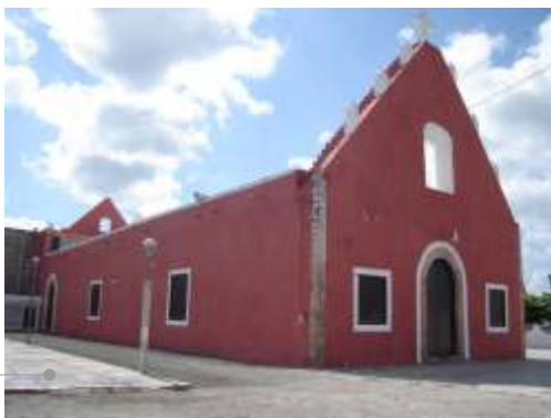
FACHADA DEL INMUEBLE
