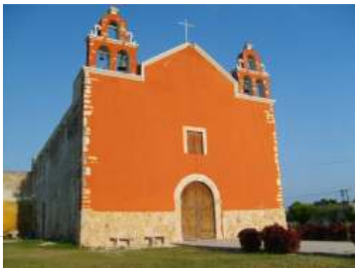
FACHADA DEL INMUEBLE
