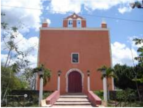
FACHADA DEL INMUEBLE
