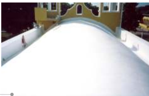
Sistema de impermeabilización acrílico en la azotea
