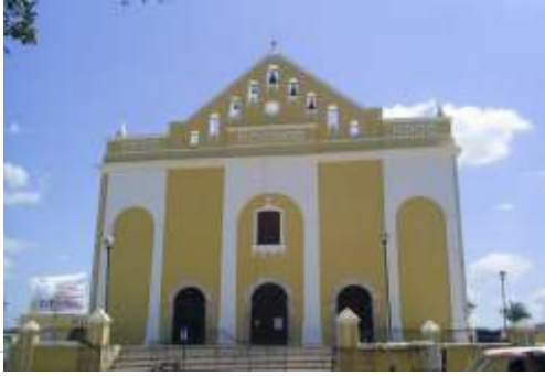
FACHADA DEL INMUEBLE
