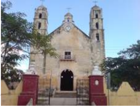
FACHADA DEL INMUEBLE
