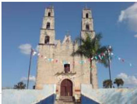
FACHADA DEL INMUEBLE
