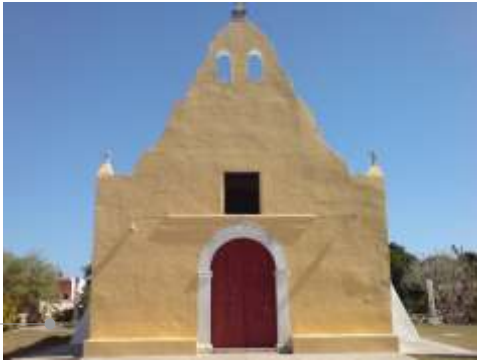
FACHADA DEL INMUEBLE
