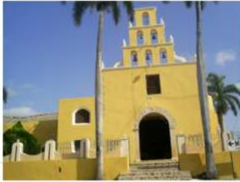
FACHADA DEL INMUEBLE
