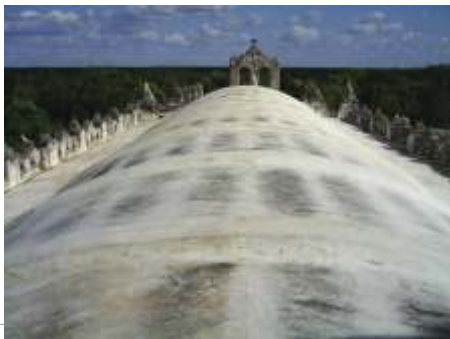
Sistema de impermeabilización acrílico en la azotea
