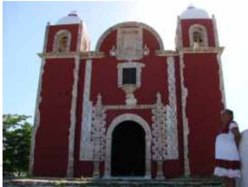
FACHADA DEL INMUEBLE
