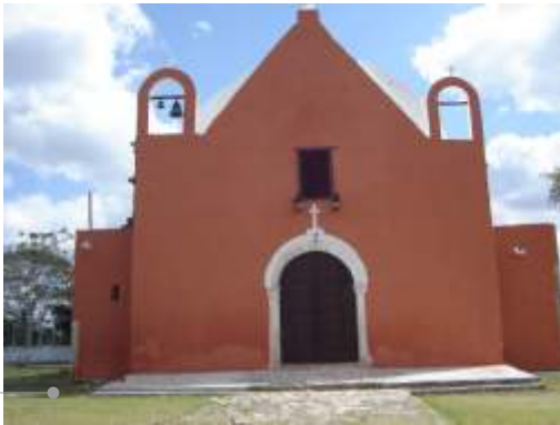
FACHADA DEL INMUEBLE
