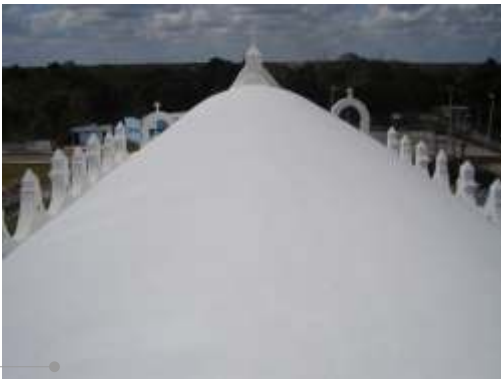
Sistema de impermeabilización acrílico en la azotea
