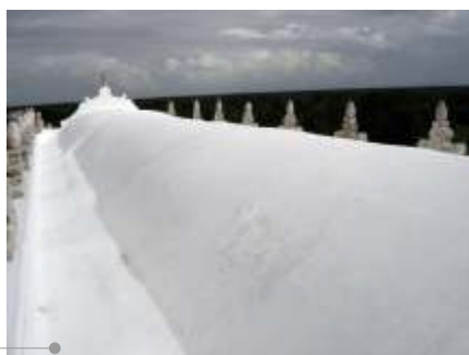
Sistema de impermeabilización acrílico en la azotea
