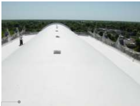
Sistema de impermeabilización acrílico en la azotea
