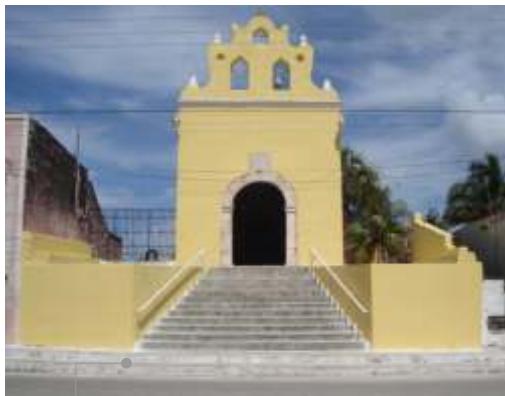
FACHADA DEL INMUEBLE
