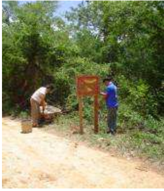
Fig. 13.-Trabajos de señalización
