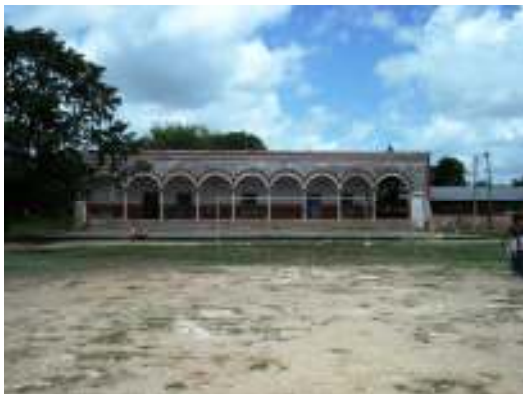
Fotografía 1. Vista de la fachada principal.
