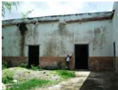
Fotografía 4. Vista de los muros exteriores del patio interior.
