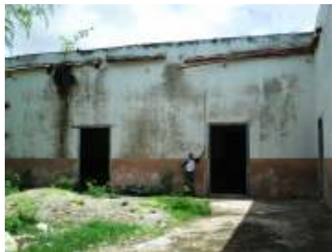
Fotografía 4. Vista de los muros exteriores del patio interior.
