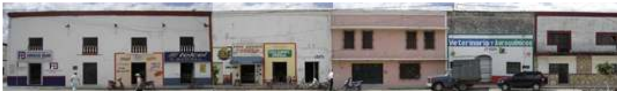
Fotografía 1. Vista de predios del paramento poniente
