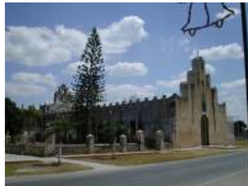
Fotografía 2. Vista de la fachada lateral.
