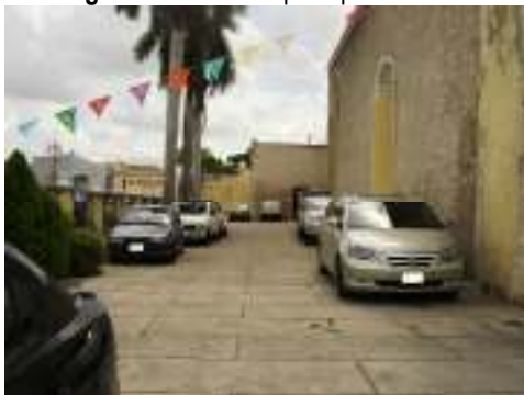
Fotografía 3. Vista parcial de la fachada norte. Se observa que el atrio se utiliza como estacionamiento público.
