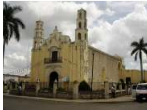
Fotografía 2. Vista fachada lateral suroeste
