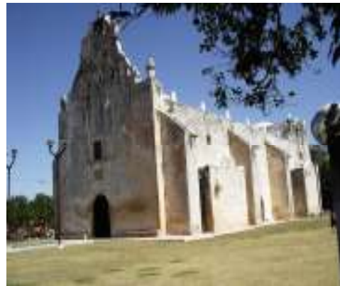
Fotografía 2. Vista lateral del templo
