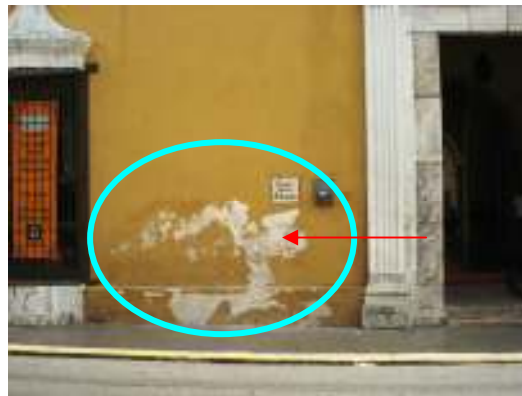
Fotografía 2. Detalle en muro. Se observan eflorescencias y desprendimiento de acabado.
