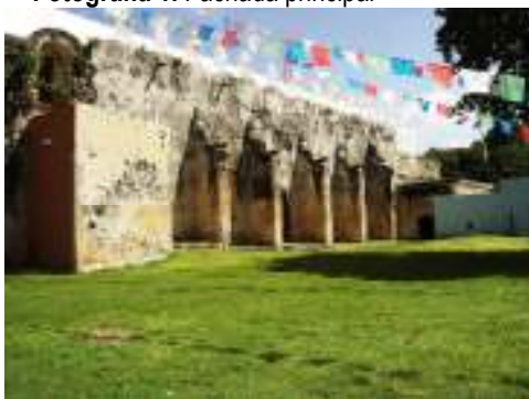
Fotografía 3. Vista de la fachada sur. Se observa al fondo la casa cural anexa.
