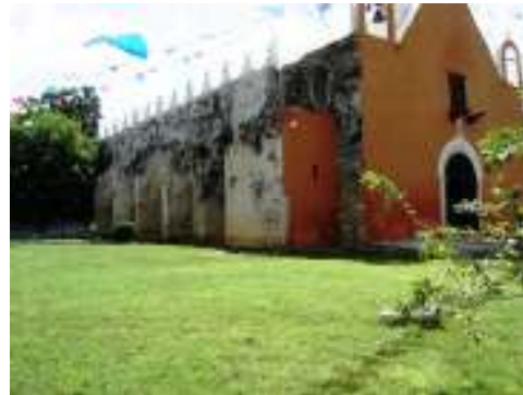
Fotografía 2. Vista fachada lateral norte
