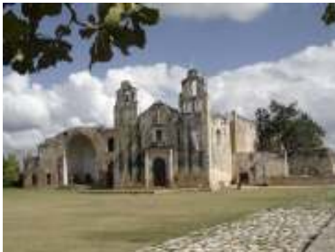
Fotografía 1. Vista de la fachada principal y del ex convento.
