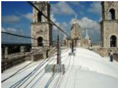
Fotografía 3. Vista de la azotea, desde el presbiterio hacia la fachada principal.
