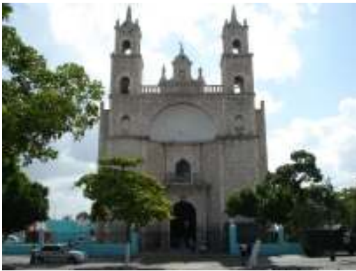
Fotografía 1. Vista de Fachada Principal.
