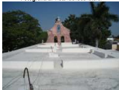
Fotografía 4. Vista general de azotea. Se observa la existencia de un sistema de impermeabilización acrílica.
