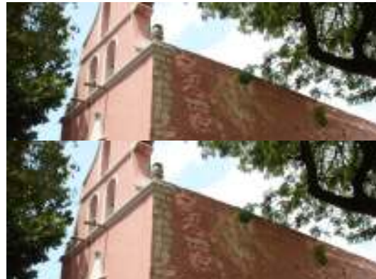
Fotografía 2. Vista fachada lateral
