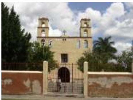
Fotografía 1. Vista de la fachada principal
