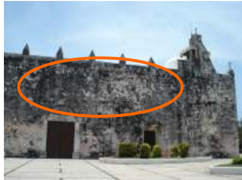
Fotografía 2. Vista lateral. Se observa manchas de humedad en muro.
