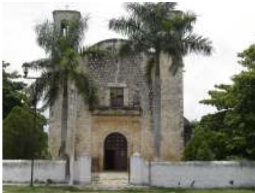
Fotografía 1. Vista de Fachada Principal.
