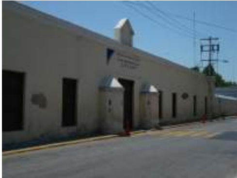
Fotografía 1. Vista de Fachada Principal.
