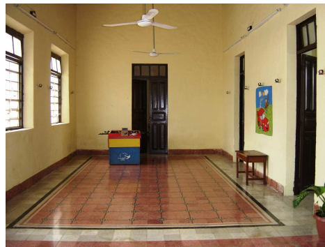
Fotografía 4. Vista general del corredor. Se observa piso de pasta
